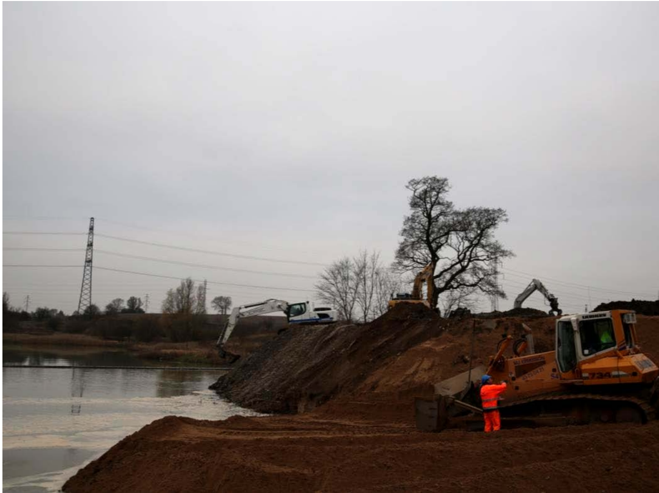
Opfyldning af Salby grusgrav
