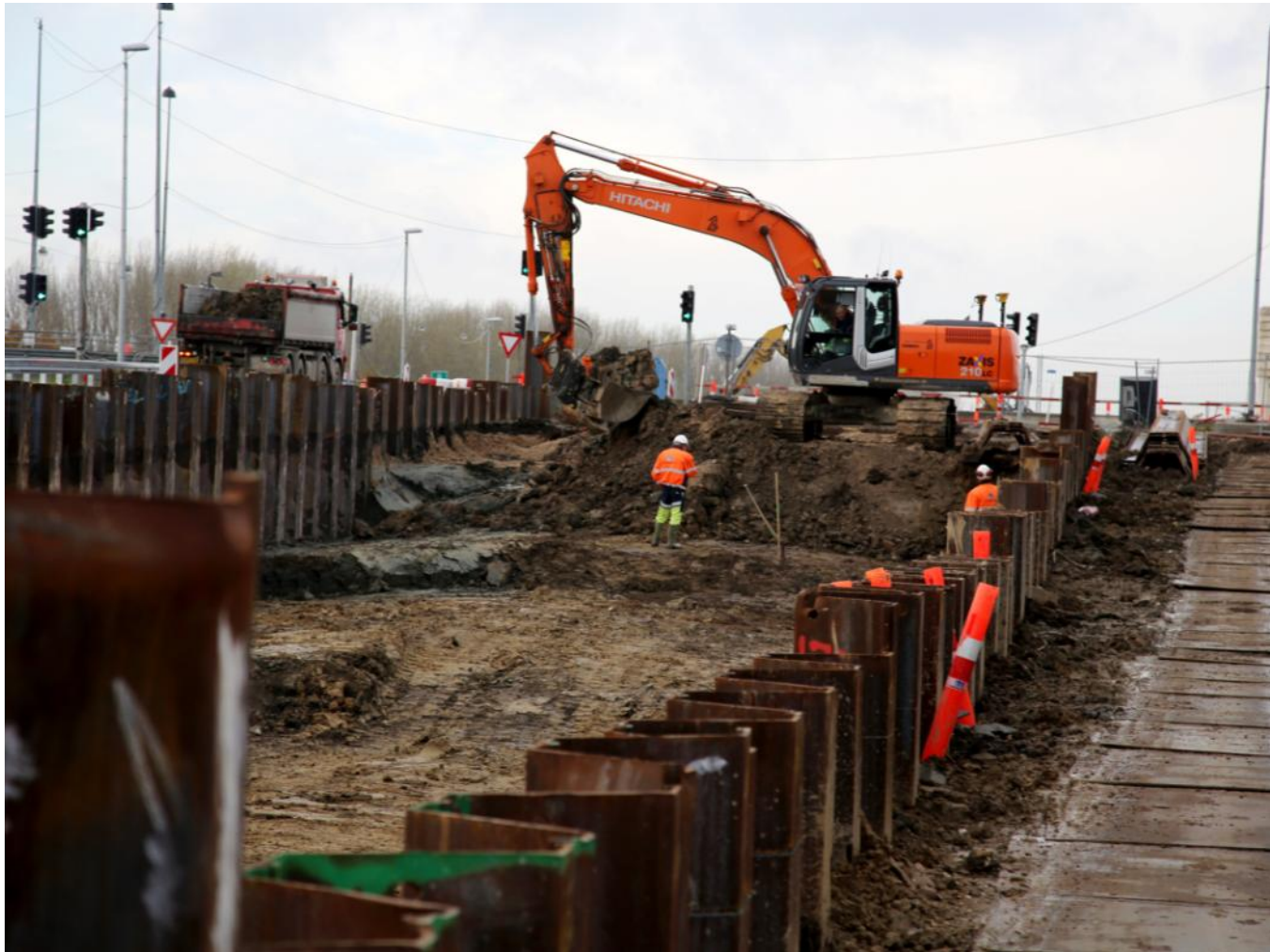
Allingvej januar 2014 - spunsarbejde
