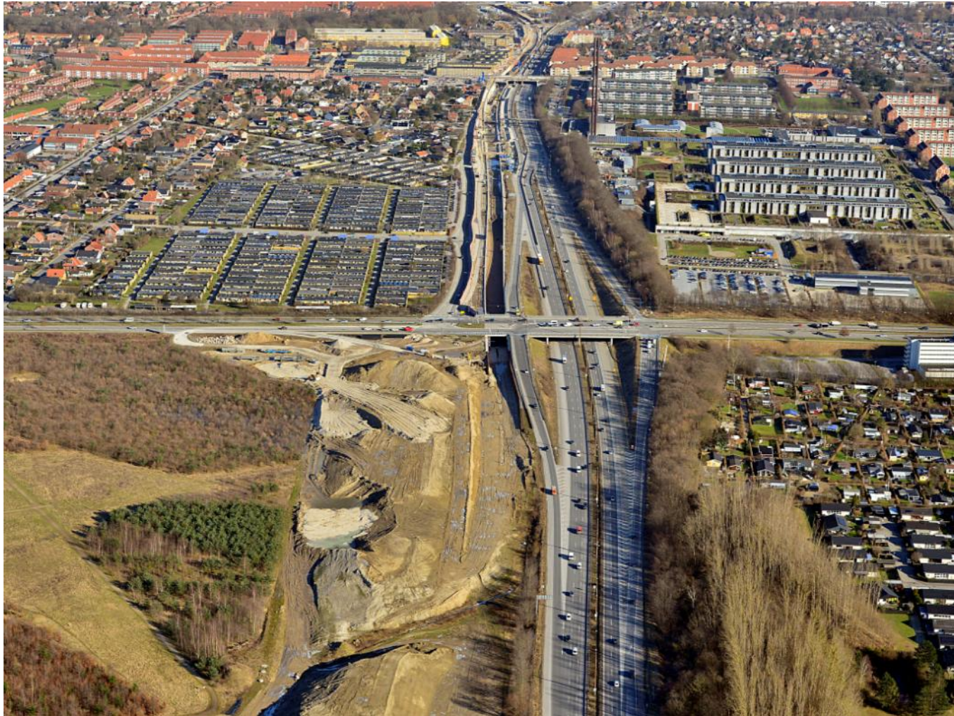
Allingvej/Avedøre Havnevej – februar 2016
